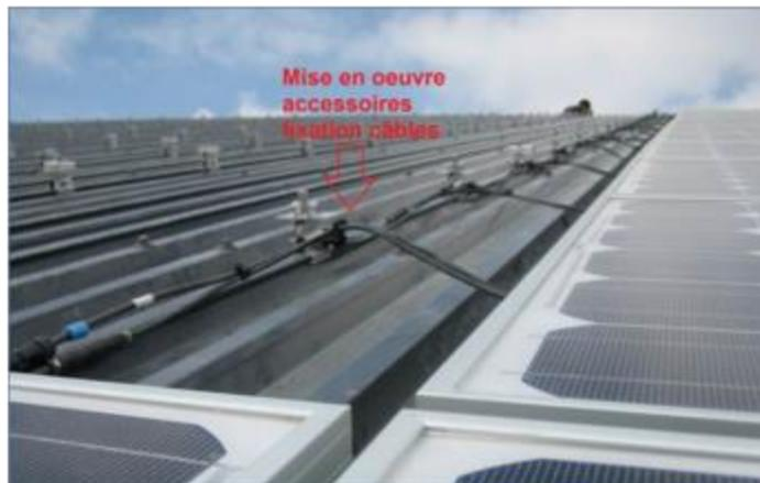
**Figure 9 – Détails sur cheminement des câbles**
